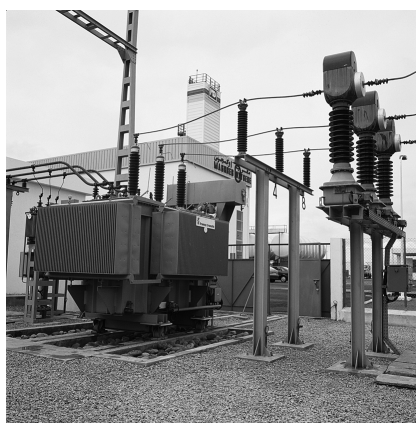
Рис. C25: Расширитель для масла с воздушной подушкой при атмосферном давлении.
