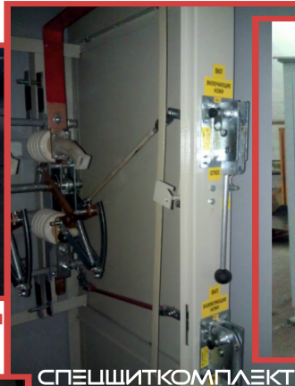
СПЕЦШИТКОМПЛЕКТ Защита от обрыва тяг приводов
