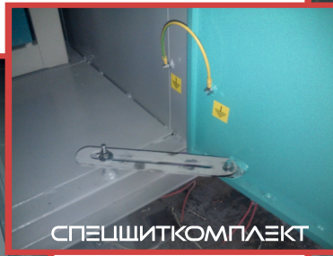
СПЕЦШИТКОМПЛЕКТ Блокируемые ограничители открытия дверей
